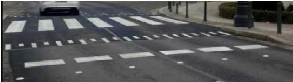
1). PRZEJŚCIE Z BETONU ASFALTOWEGO
