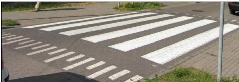
2). PRZEJŚCIE Z KOSTKI BRUKOWEJ BETONOWEJ
