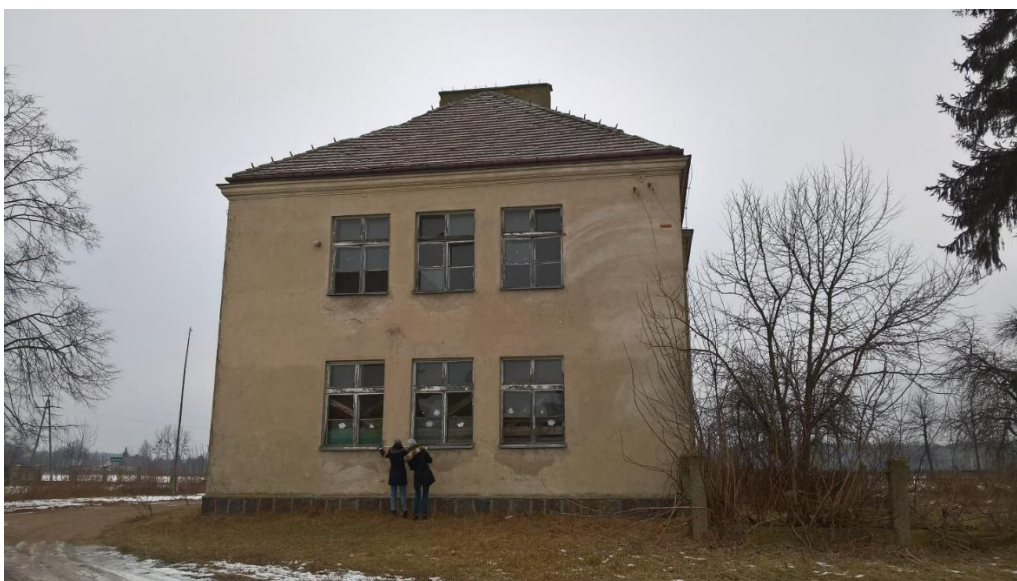
Fot. 3. Elewacja boczna
