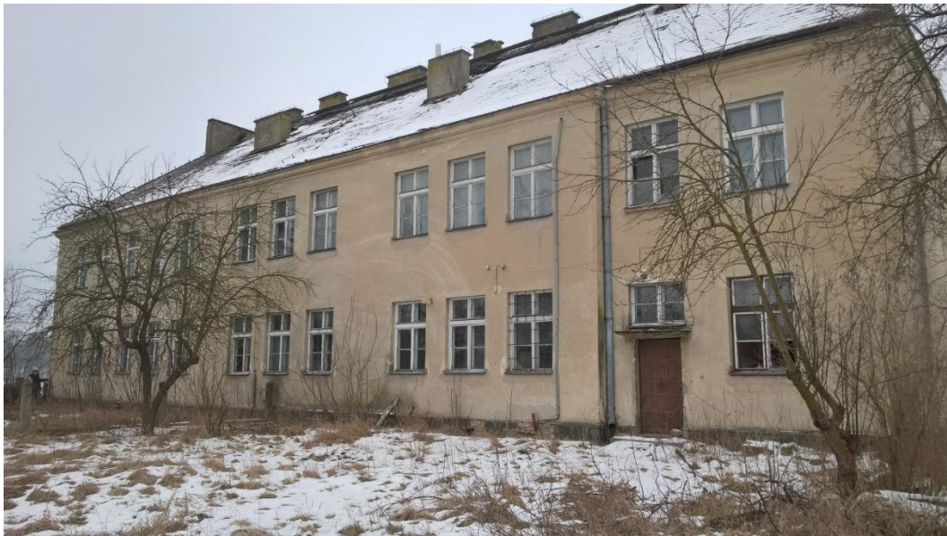
Fot. 4 Elewacja tylna
