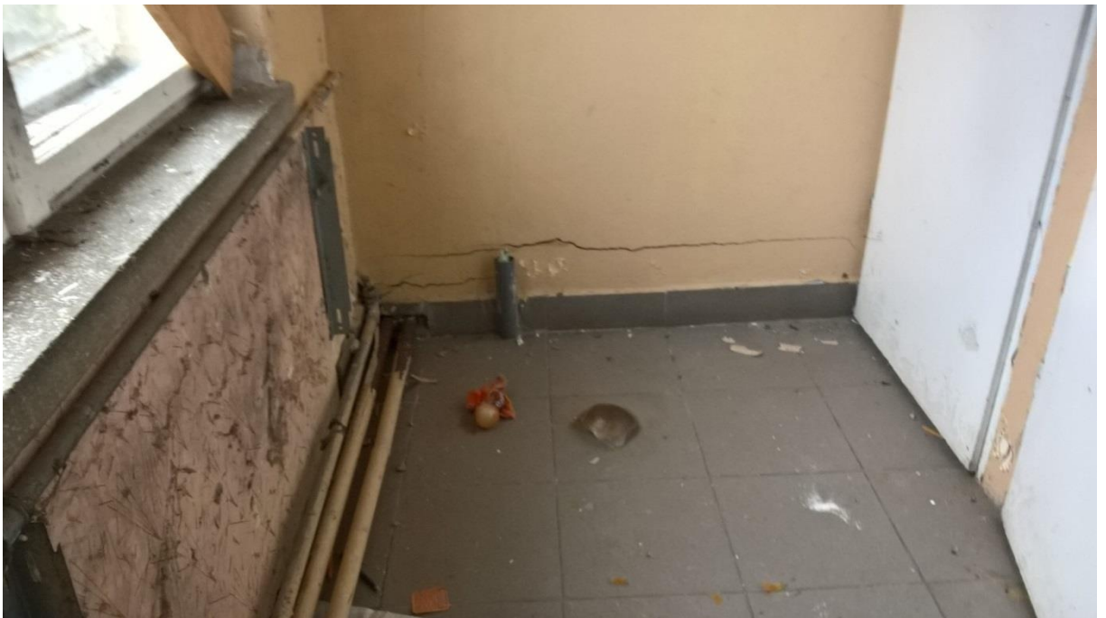
Fot. 14 Zarysowana ściana
