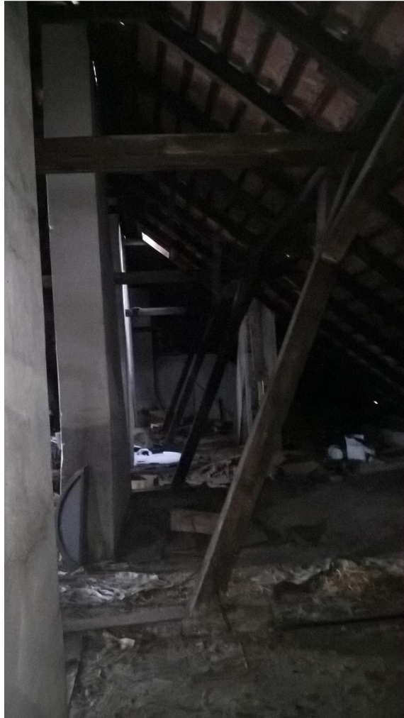
Fot. 13 Wieżba dachowa
