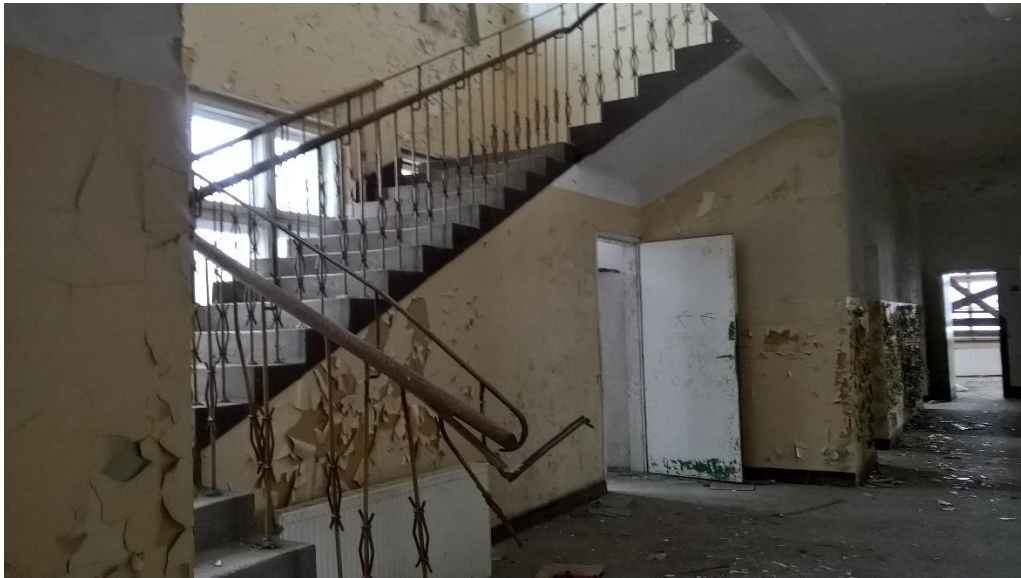
Fot. 11 Klatka schodowa
