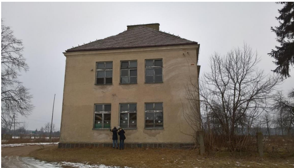
Fot. 2 Elewacja boczna
