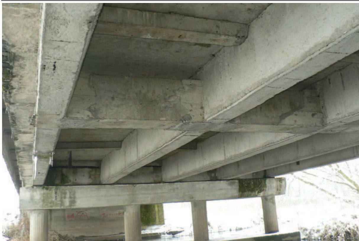
Fot. I.2 Widok na spód ustroju nośnego
