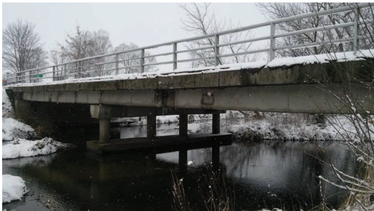
Fot. I.1 Widok z boku na obiekt
