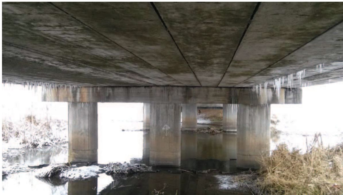
Fot. II.2 Widok na spód ustroju nośnego
