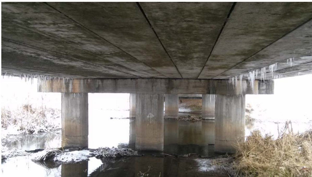
Fot. II.2 Widok na spód ustroju nośnego
