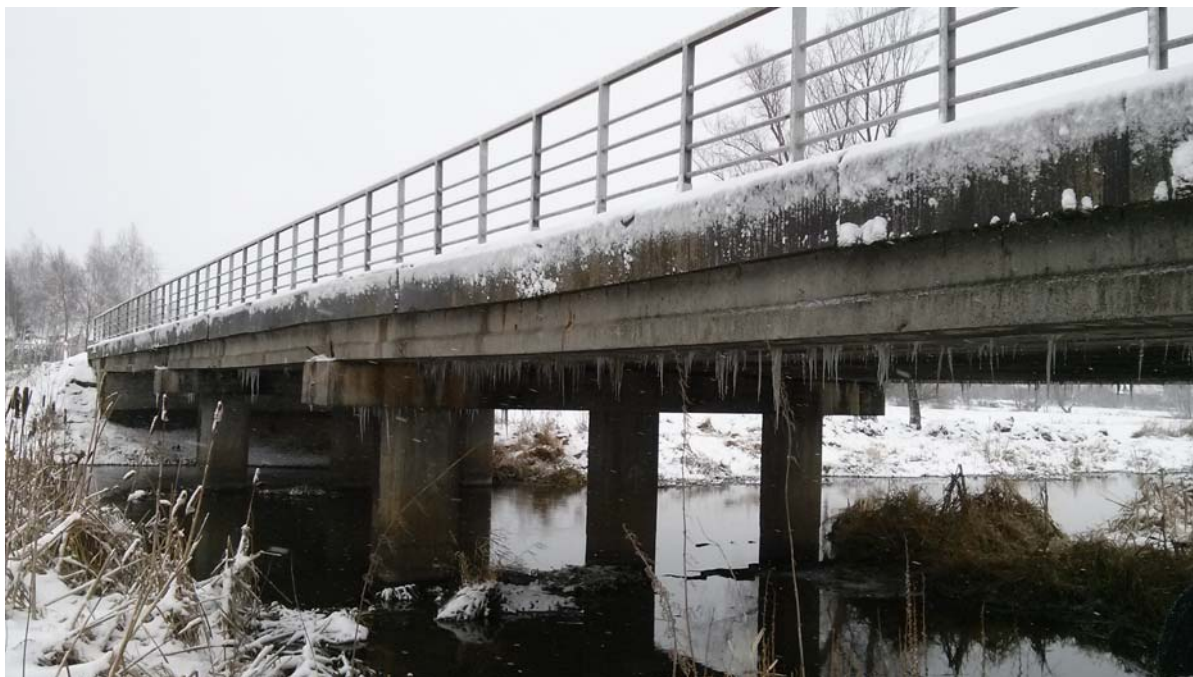
Fot. II.1 Widok z boku na obiekt
