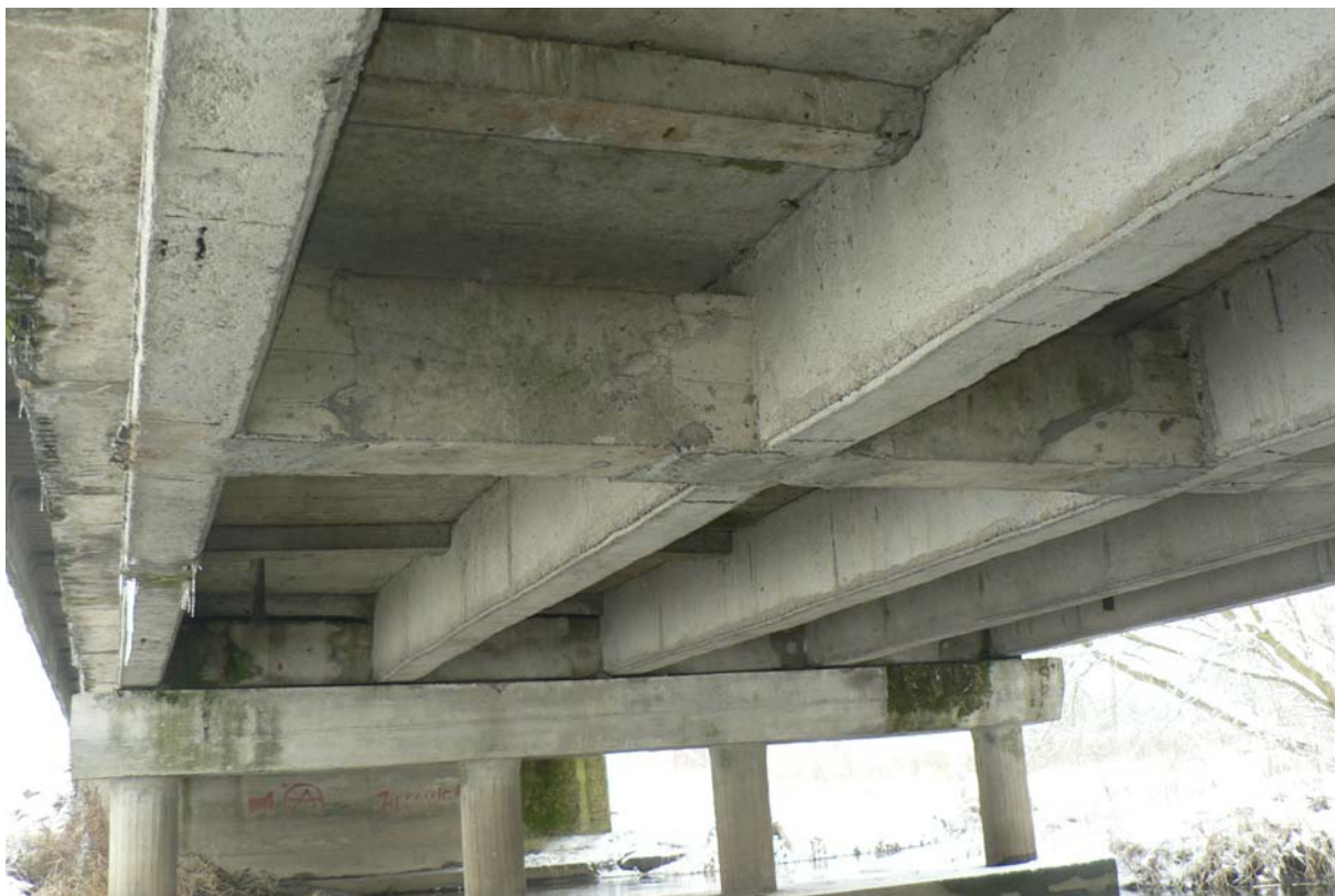
Fot. I.2 Widok na spód ustroju nośnego
