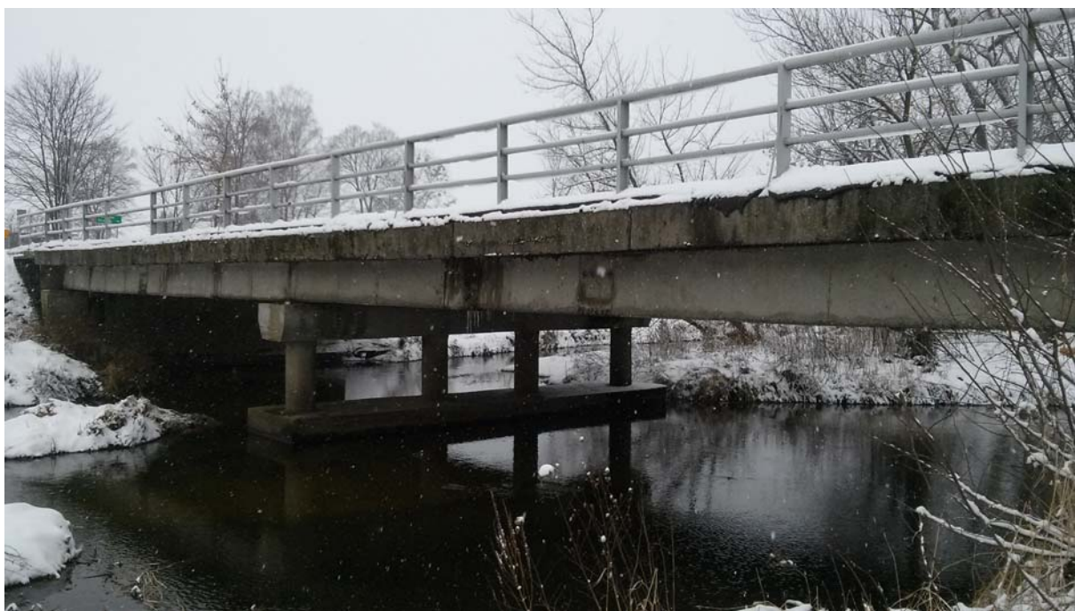
Fot. I.1 Widok z boku na obiekt
