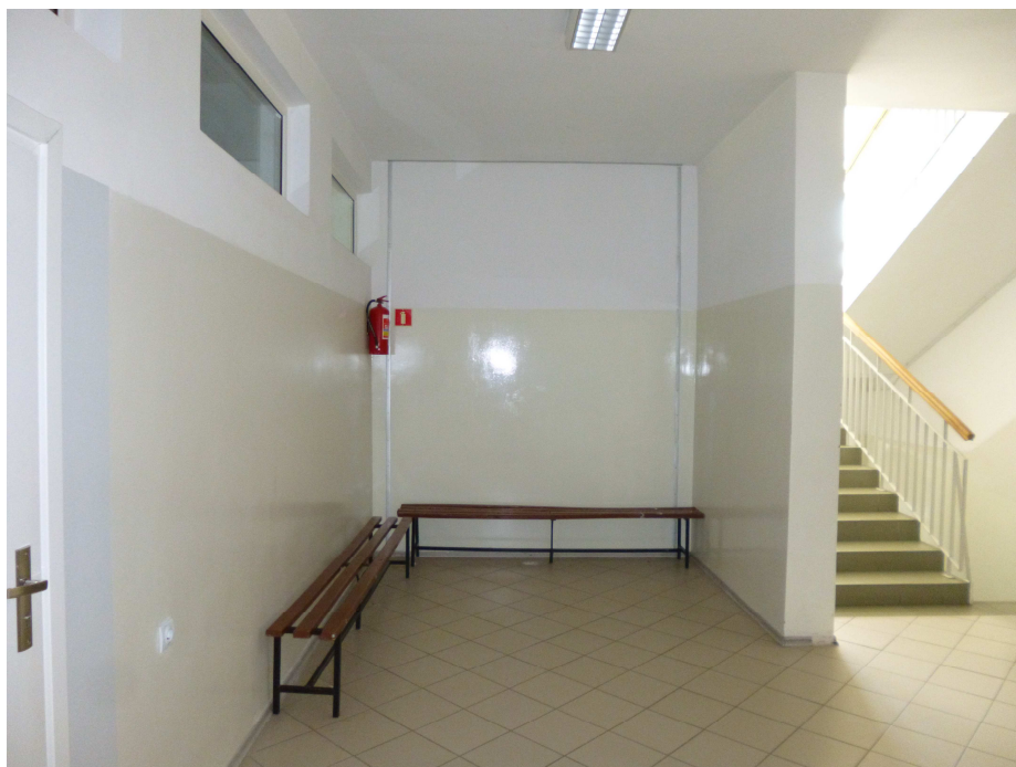
Fot. 4 – Klatka schodowa, w głębi ściana za którą znajduje się szyb windowy (1).
