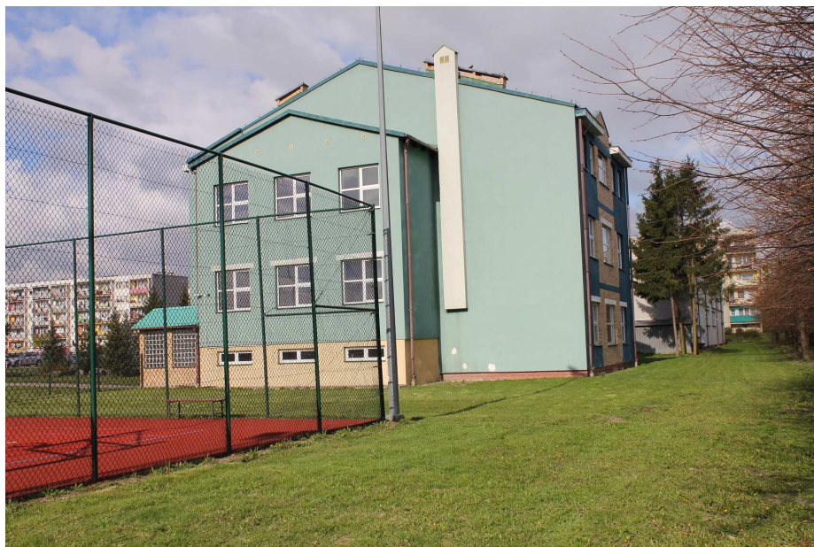
Fot. 3 – Miejsce lokalizacji sali koncertowej (2).
