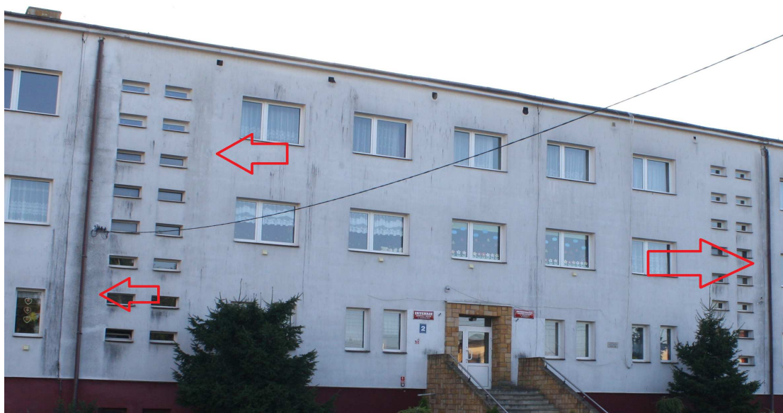
Z.9 – odgrzybienie i malowanie elewacji
