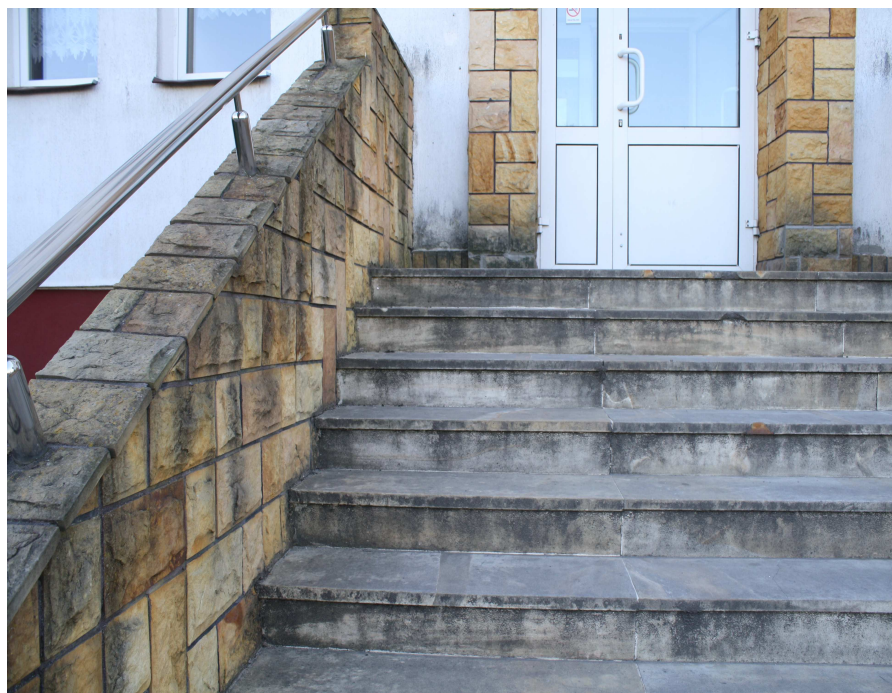
Z.10 – wyczyszczenie i odgrzybienie schodów
