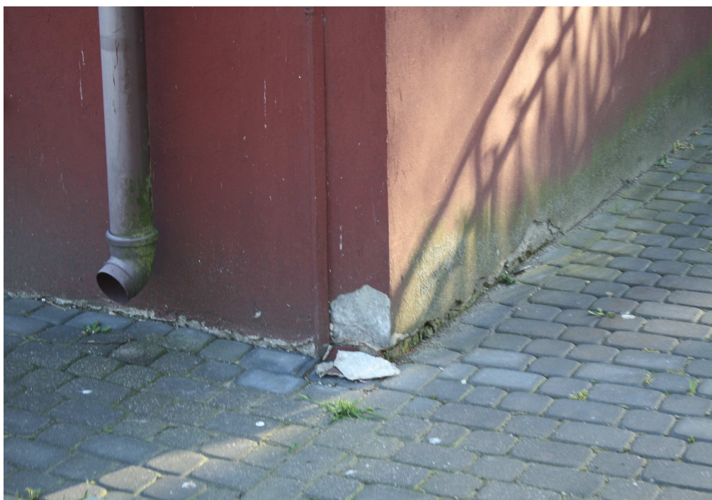
Z.11 – naprawa styropianu i montaż nowych kratek wentylacyjnych
