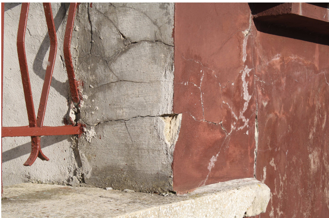
Z.6 – tynk na cokole
