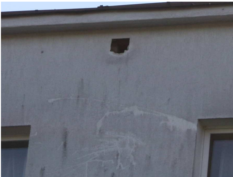
Z.11 – naprawa styropianu i montaż nowych kratek wentylacyjnych
