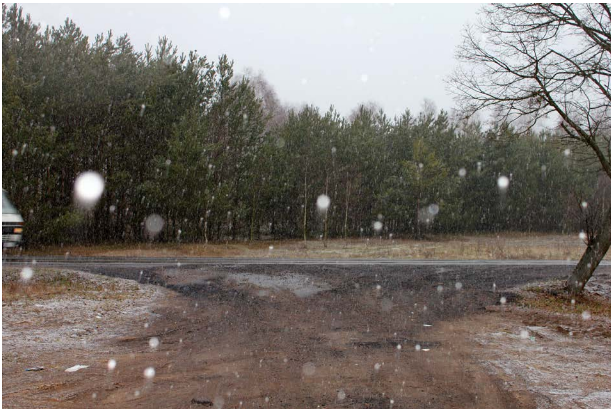
Zjazd nr 4 – istniejący wyjazd z terenu strefy na drogę krajową nr 57 z drogi powiatowej (niedokończonej) na działkach nr 156/1 i 156/2. Planowane ukończenie drogi i włączenie jej do drogi 57 w 2016 r.
