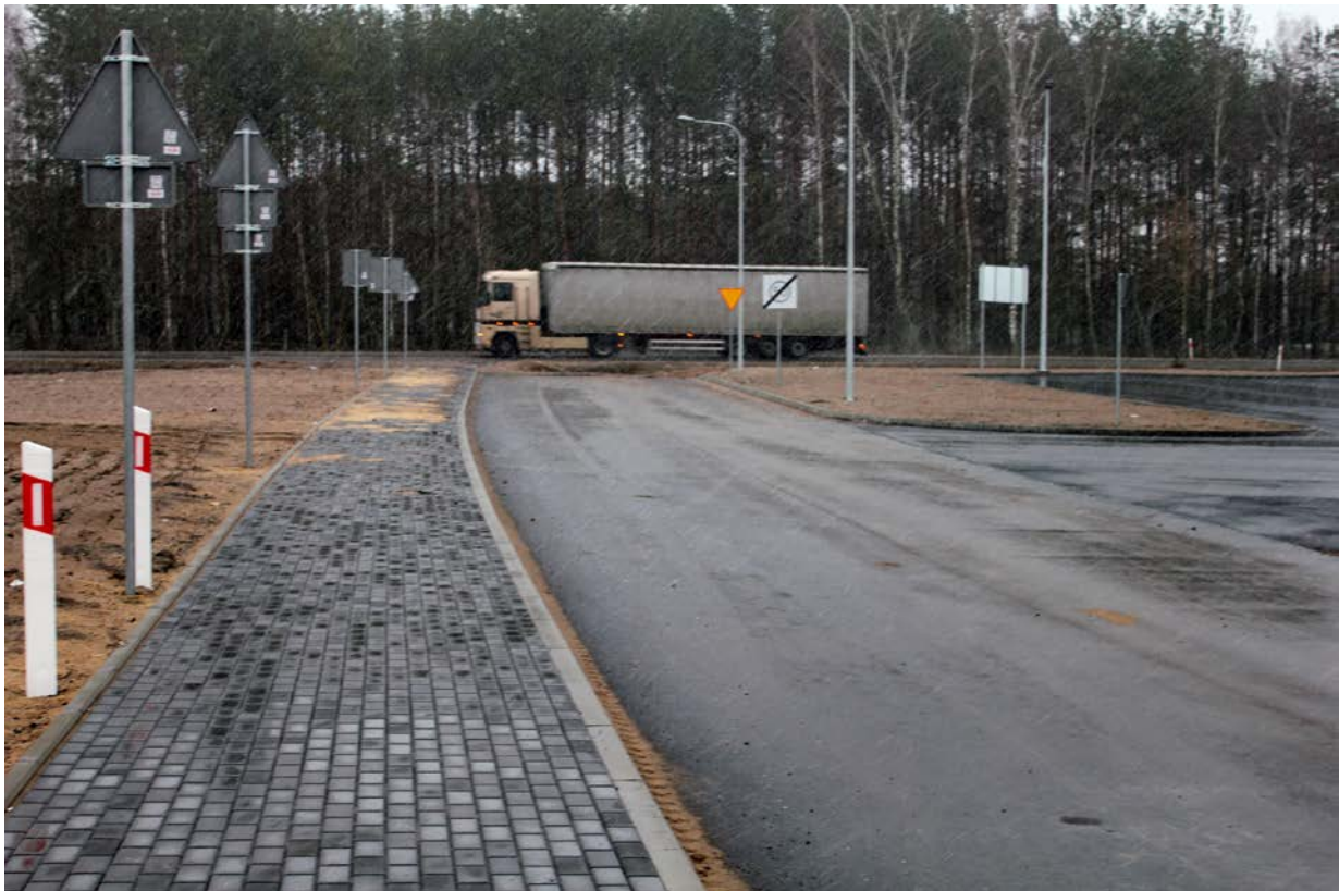
Zjazd nr 2 – wyjazd z terenu strefy na drogę wojewódzką nr 614
