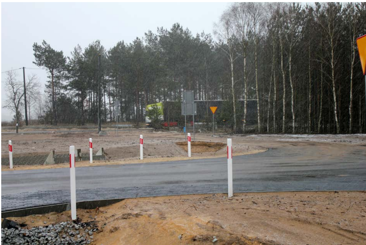
Zjazd nr 1 – wyjazd z terenu strefy na drogę wojewódzką nr 614
