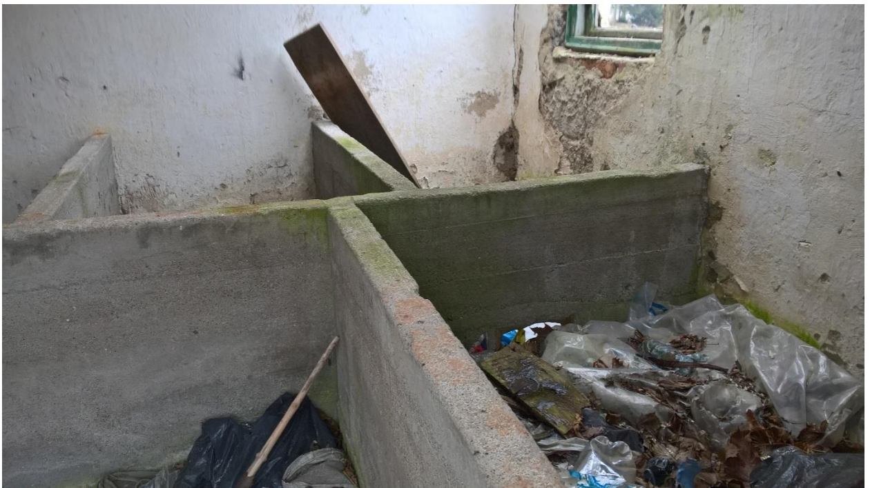
Fot. 4 skrzynie betonowe
