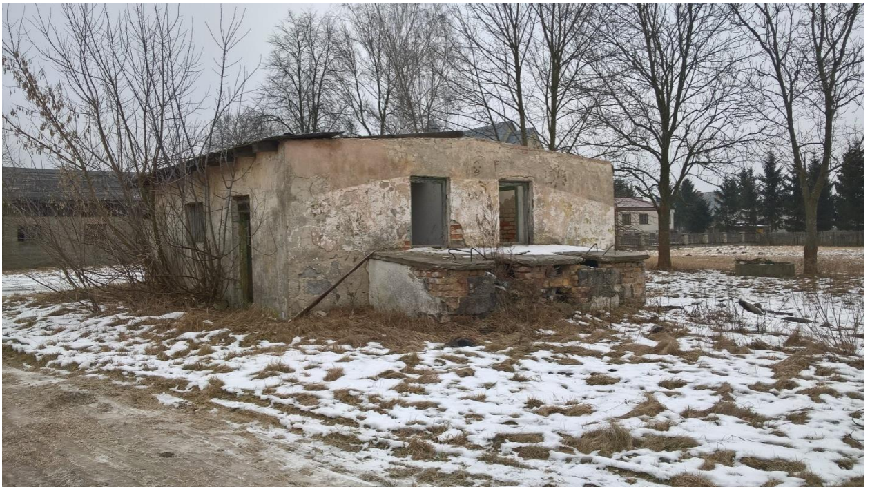
Fot. 2 Elewacja budynku
