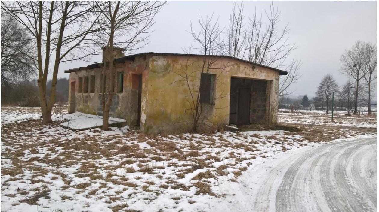
Fot. 1 Elewacja budynku
