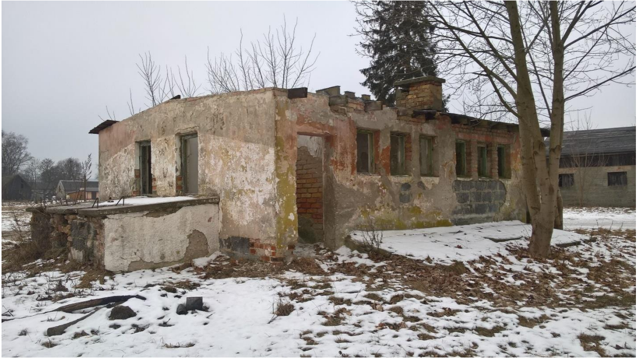
Fot. 3 Elewacja budynku
