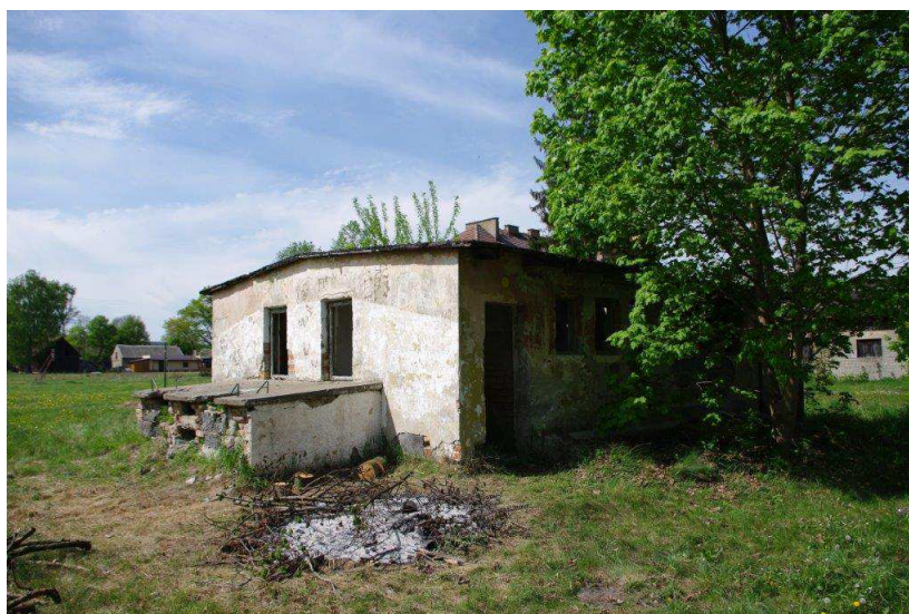
Fot. 2 – Widok budynku (2).
