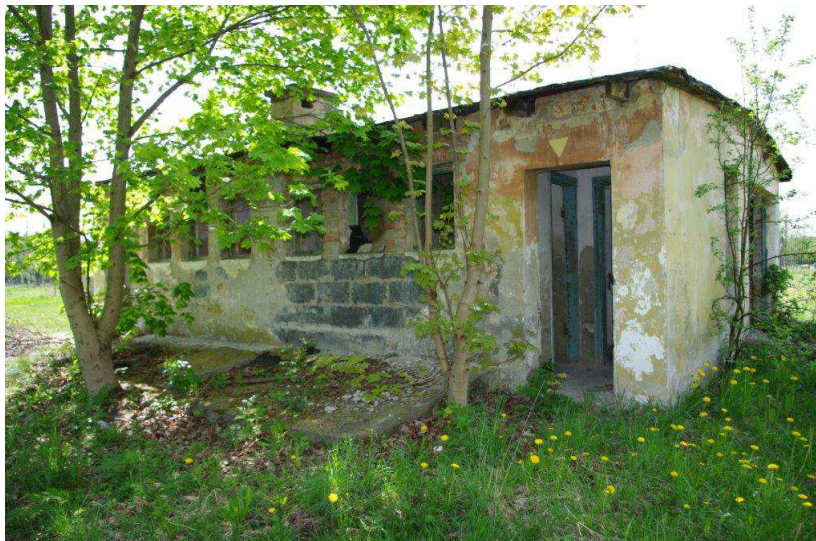
Fot. 1 – Widok budynku (1).
