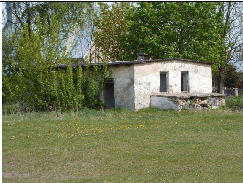
Fot. 3 – Widok budynku (3).
